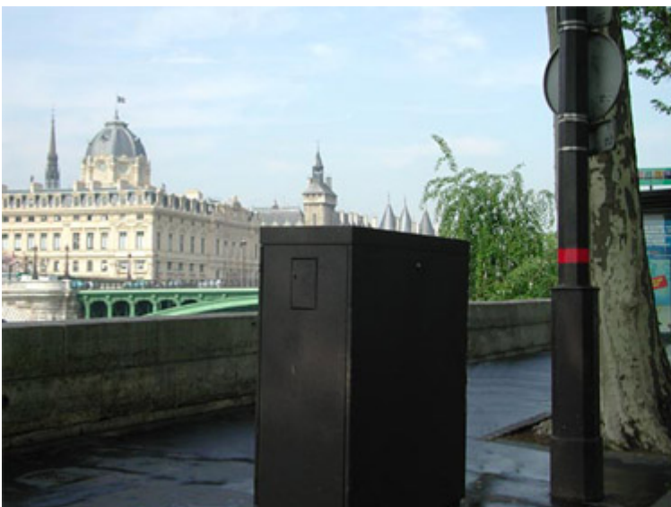
Armoire à feux pour la gestion d'un carrefour. Paris, dans l'axe de la Conciergerie. Forêt de feux au carrefour de l'avenue de Wagram à Paris. © Frédéric Héran.
