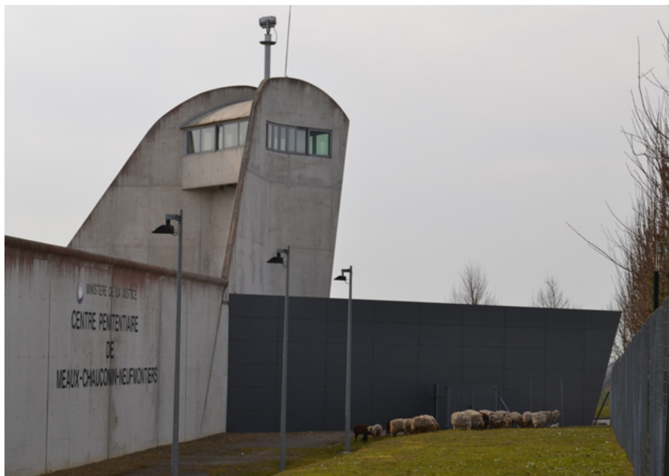
Site du centre pénitentiaire de Meaux-Chauconin-Neufmontiers – Client : Ministère de la Justice
