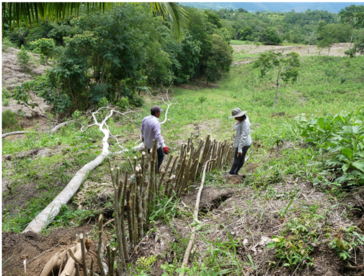
Implantation des "barreras vivas" pour lutter contre l'érosion © Coquin Bertrand
