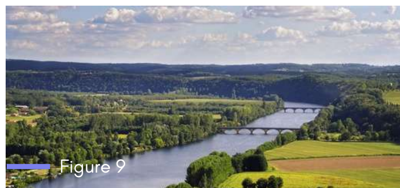
Figure 9 pont routier et ferroviaire de Trémolat vers Calès
