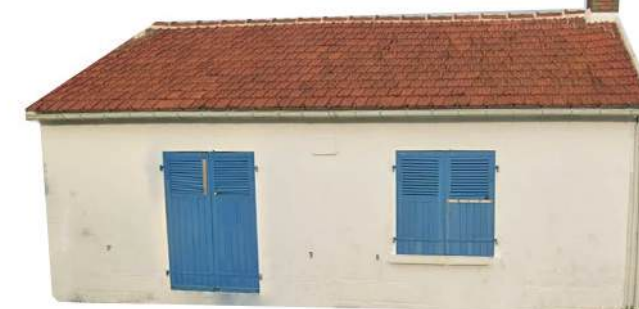
Maison caractéristique du lotissement Photographie issue de Google Maps
