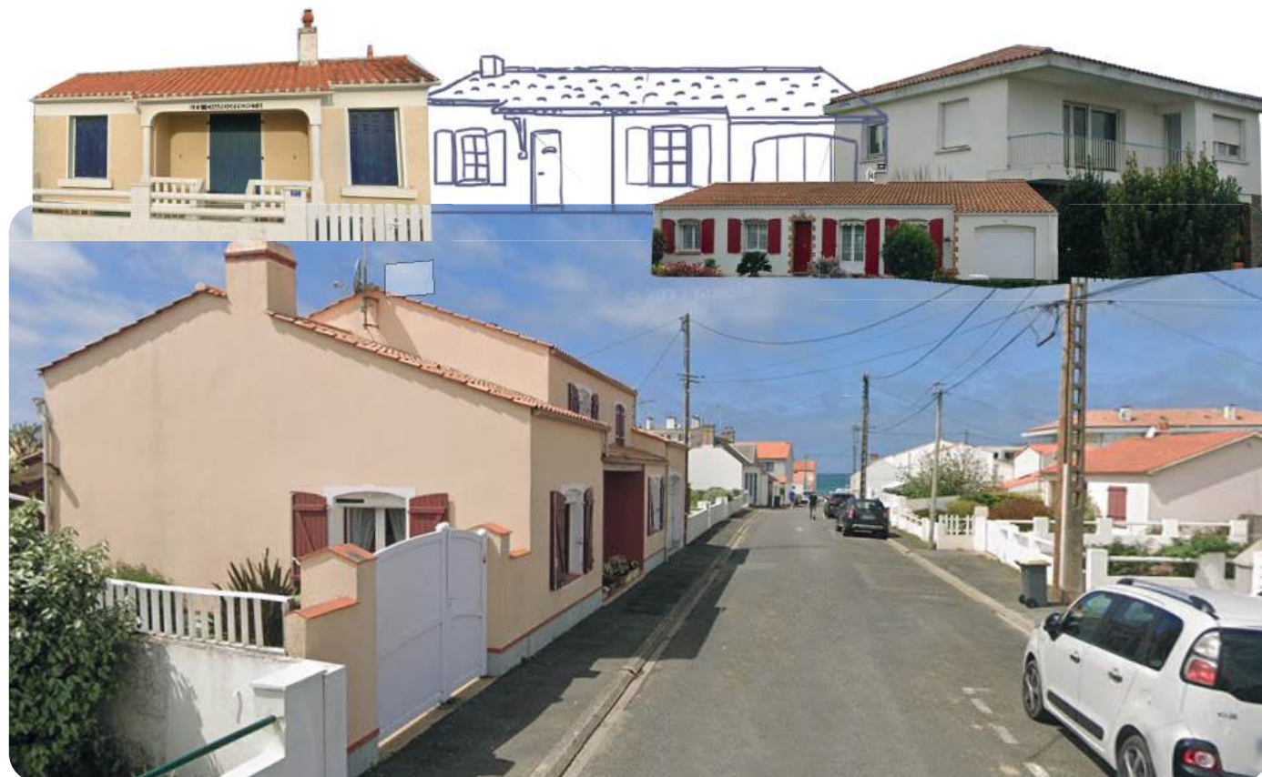
Typologie caractéristique des rues du lotissement : large voirie, trottoir étroit, des maisons individuelles, absence d'espace public davantage localisé sur le front de mer. Photographie issue de Google Maps
