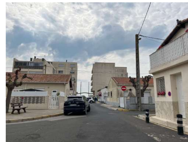
Bâti de la station balnéaire du Grau d'Agde.
