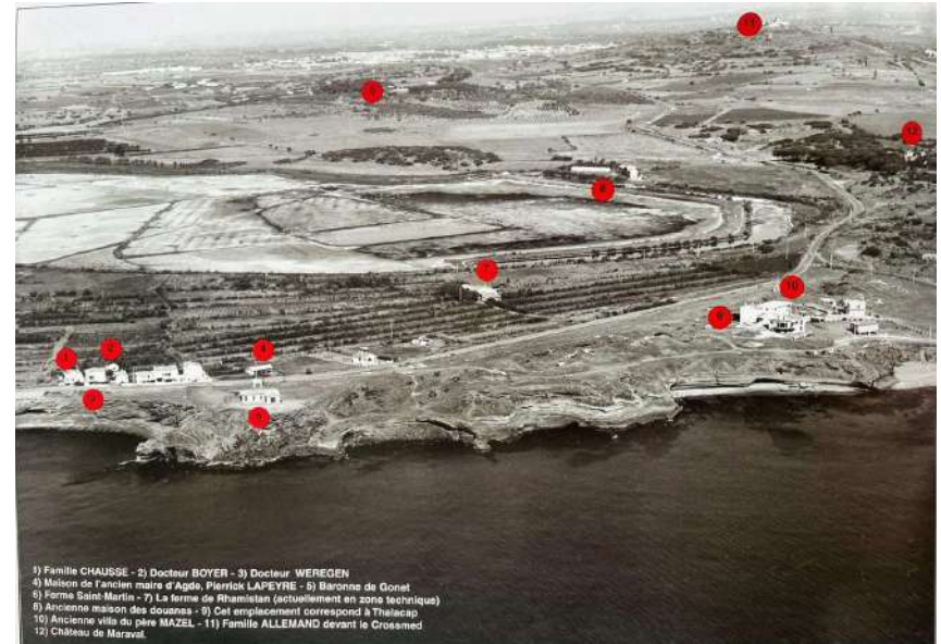
Vue plongeante sur le Cap d'Agde avant les travaux. Cap d'Agde 1970 - 2000, L'histoire de la plus grande station touristique française
