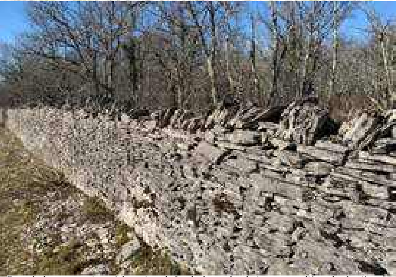
▲ Exemple de muret en pierre sèche typique du Lot, les lauzes de calcaires sont empliées et les dernières sont positionnées à la verticale afin d’ éviter la stagnation d’ eau et par conséquent le gel.
