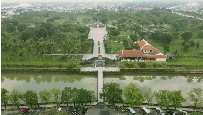
Vue actuelle de la Citadelle de Quang Tri, Axe nord-sud : la porte sud, le restaurant, le tertre du mausolée au centre et croisée des deux Axes Nord-Sud et Est-Ouest, le petit musée sur la droite, les vestiges de la porte nord. Source : © DE-SO Asia & UDI. 2022
