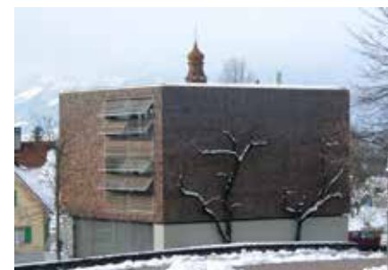
Röthis - Bureaux, architecte Reinhard Drexel, Hohenems
