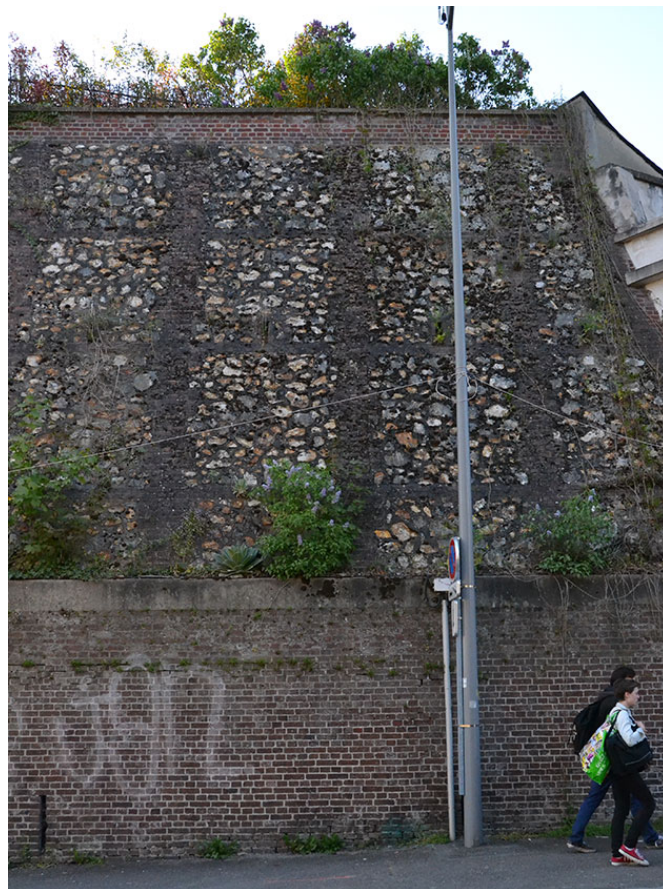
Mur de soutènement colonisé par le végétal à Rouen.
