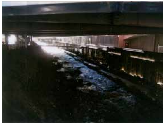
Passage contraint sous la RN90, à l'Est de Moûtiers
