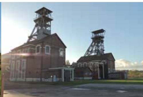
Figure 2.10. Fosse d'extraction 9-9bis
