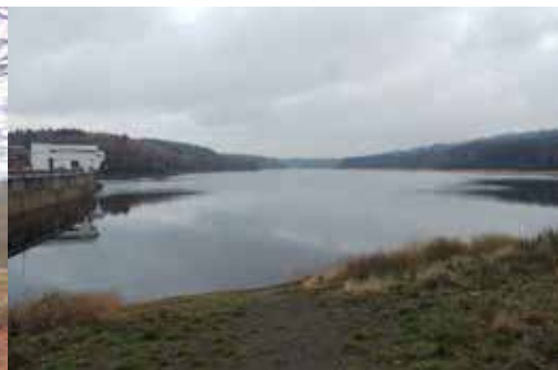
Figure 2.37. Barrage et retenue d'eau
