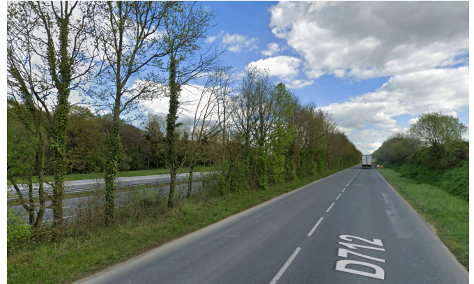
Haie filtre entre l'ancienne et la nouvelle RN12 © Google street view / Avril 2022
