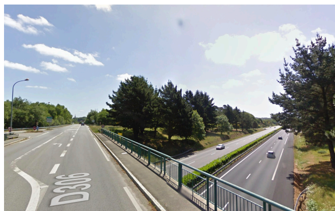
Mise en valeur des délaissés routiers sur la RN165 © Google street view / Mai 2011
