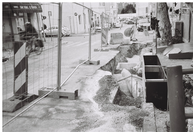
2025_02 Vues sur le chantier boulevard De Roux à l'angle avec la rue Saint-Bruno, Marseille 4 e , ©Olivia Fert
