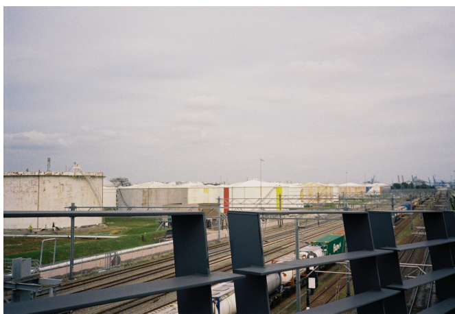
Réservoirs, Port industriel de Rotterdam, 2025 ©Olivia Fert
