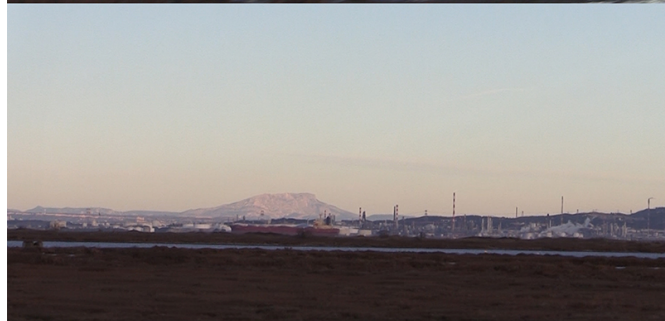
Réservoirs, Port industriel de Rotterdam, 2025 ©Olivia Fert
