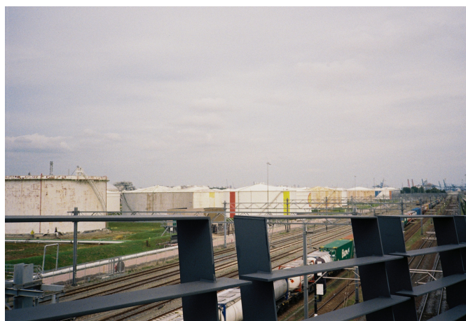
Réservoirs, Port industriel de Rotterdam, 2025 ©Olivia Fert
