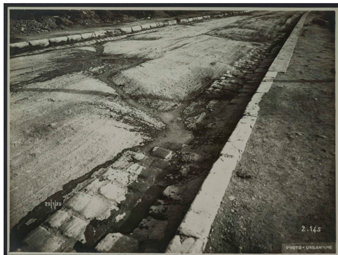
Une chaussée ravinée dans une rue non identifiée, avant l'utilisation d'enrobés Marseille, 1935 ©Jean-Baptiste Ribotta ; Archives de la Ville de Marseille, 195 Fi 110
