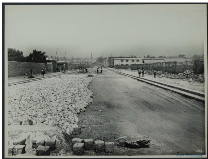
Travaux de voirie, pavage, dans une rue non identifiée, Marseille, 1946 ©Jean-Baptiste Ribotta ; Archives de la Ville de Marseille, 195 Fi 412
