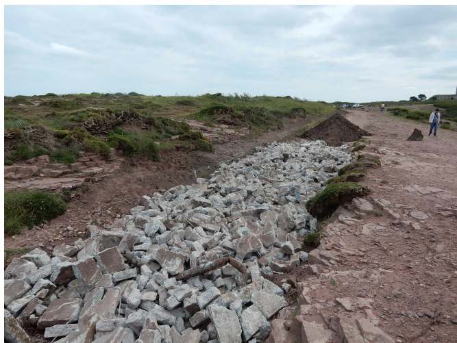
Le réemploi des produits de démolition. ©Alain Freytet
